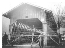
Pont frontalier entre Bangs (AT) et Rüti (CH), vers 1939/1940. © Jüdisches Museum Hohenems Archiv, en provenance des Stadt-archiv Dornbirn
